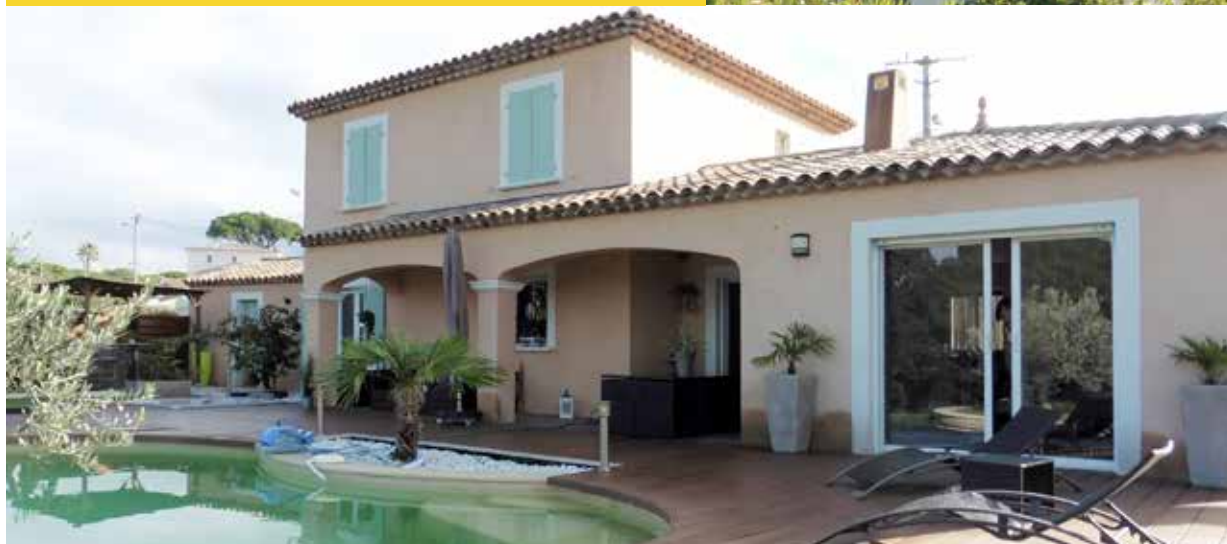
Construction de 2 villas
