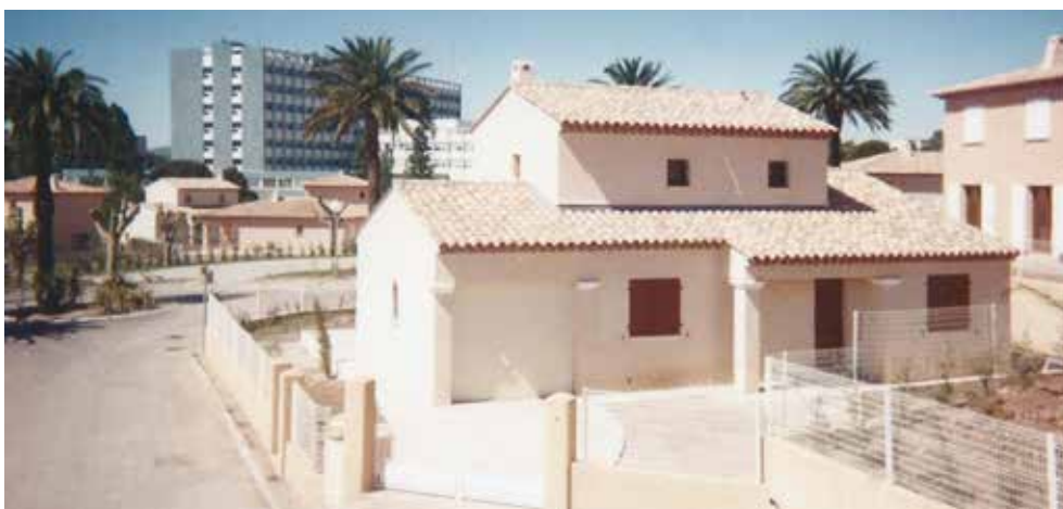
Construction d'un lotissement de 21 villas
