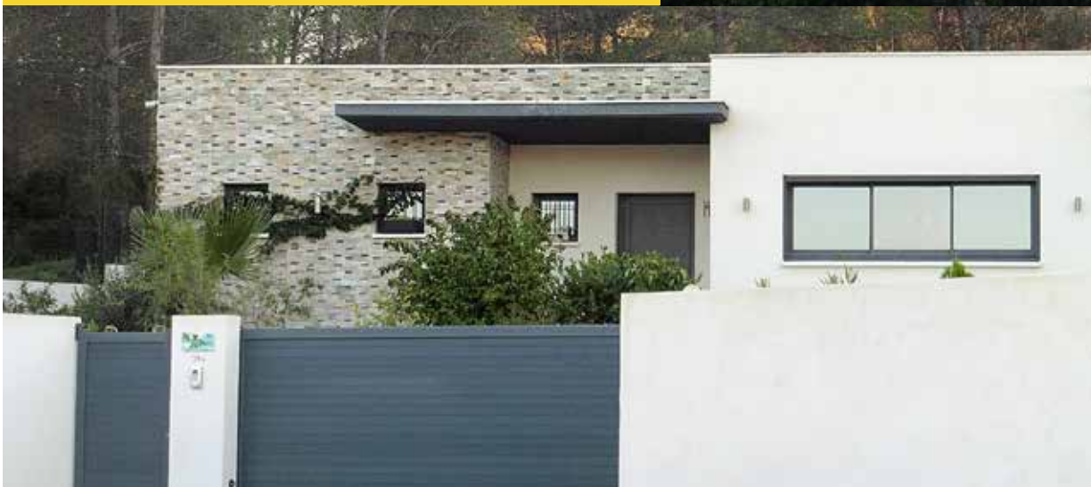
Construction de 2 villas
