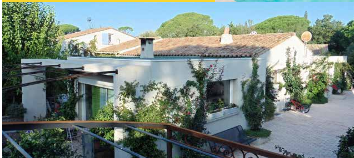
Construction de 1 villa
